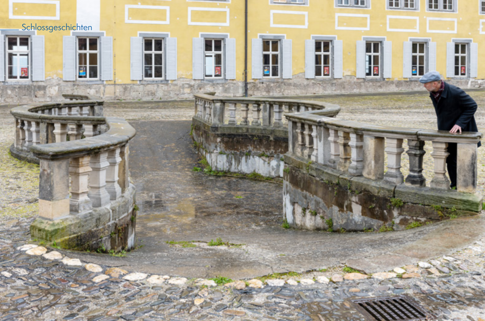
Peter Wittwar ist Bauhistoriker, begleitet die Bauforschung im Marstall. Hier steht er vor einer historischen Pferdewaschanlage.
