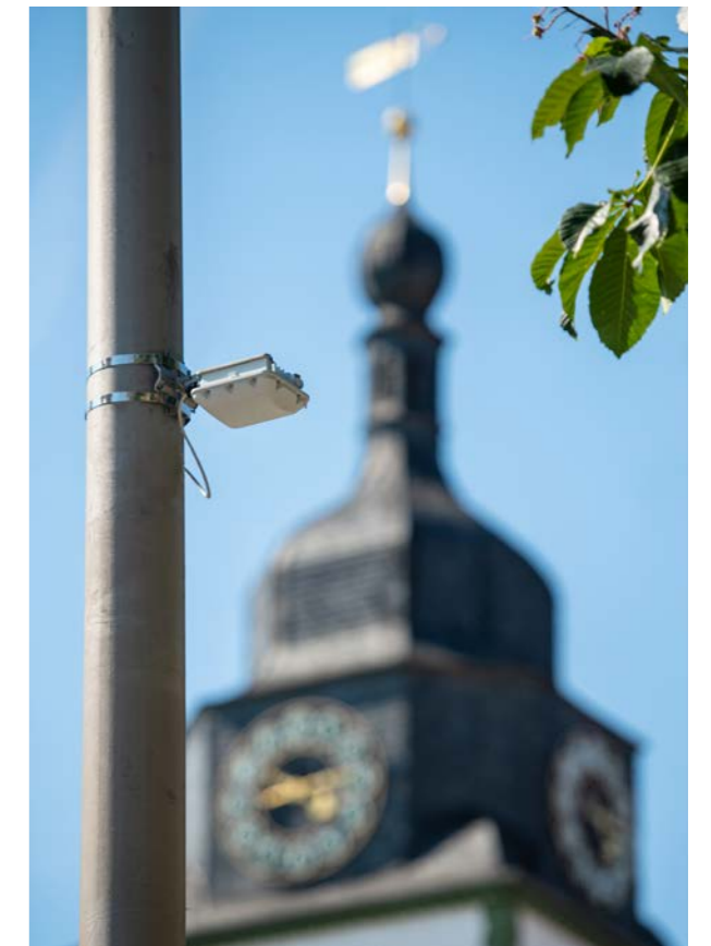
Wer weiß, wo er suchen muss, wird an gleich mehreren Straßenlaternen in der Innenstadt die WiFi-Verteiler entdecken. Sie ermöglichen das kostenlose mobile Surfen.
