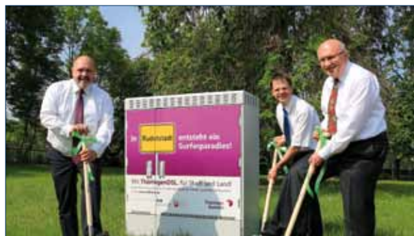
Foto (Stemplewitz): Rudolstadts Bürgermeister Jörg Reichl, EVR-Vertriebsleiter Christian Engel und der Geschäftsführer der Energieversorgung Rudolstadt GmbH Werner Pods beim symbolischen Spatenstich für den Glasfaserausbau in Rudolstadt (v.l.n.r.)
