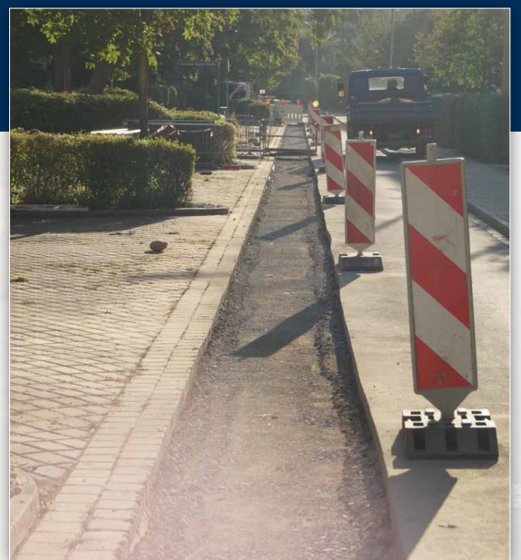
Abschließende Bauarbeiten in Schwarza-Nord (Foto: Claudia Hoffmann)
